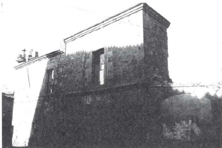
FIGURA 9. Vista del Colegio hacia la calle Cañizal antes de la restauración. Se aprecia la puerta con que se cerró el callejón.
