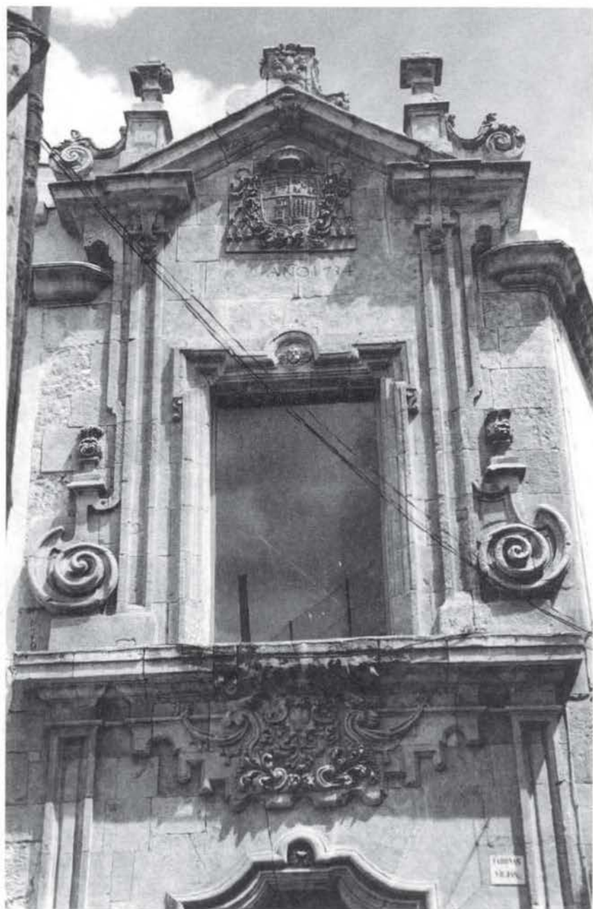
FIGURA 8. Detalle de la fachada.
