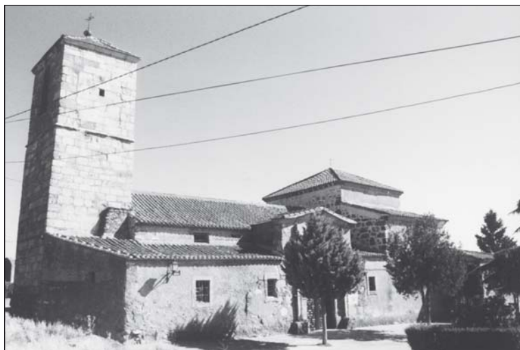
Figura 8.—Machacón. Iglesia. Exterior. Vista general
