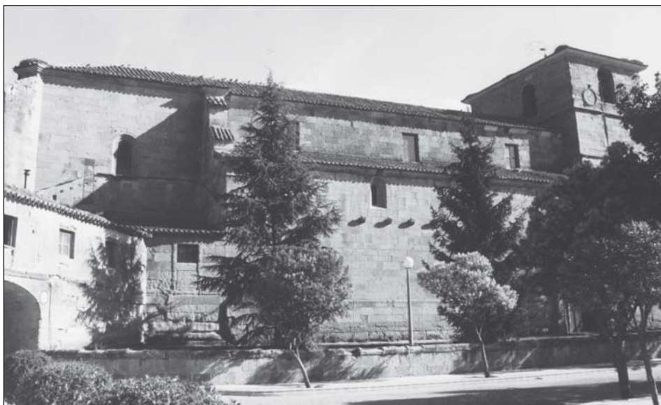
Figura 17.— Babilafuente. Iglesia. Exterior. Vista general
