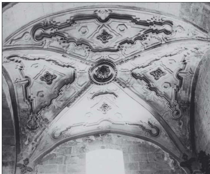
Figura 7.—Cantalpino. Iglesia. Interior. Bóveda del brazo norte del crucero ideada por fray Antonio de Manzanares a imitación de las existentes, trazadas por Juan de Sagarbinaga
