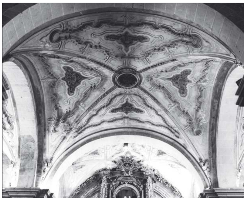
Figura 6.—Cantalpino. Iglesia. Interior. Elementos sustentados ideados por Juan de Sagarbinaga. Bóveda del crucero
