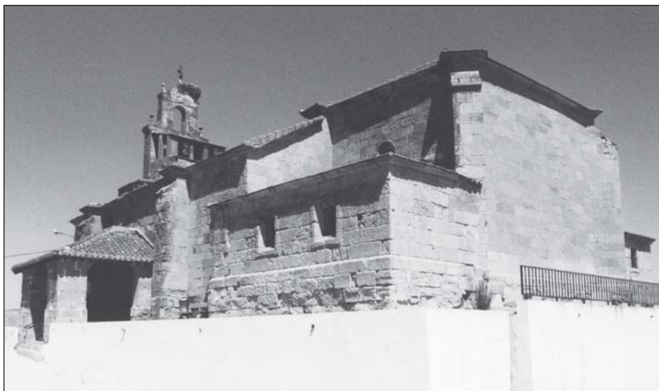
Figura 25.—Arabayona de Mójica. Iglesia. Exterior. Vista general
