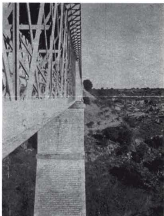
Pilar y estructura metálica del puente sobre el rio Yeltes
