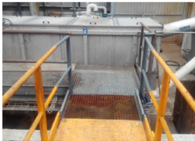
Detalle acceso habilitado
