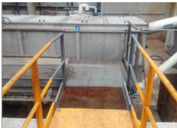
Detalle acceso habilitado
