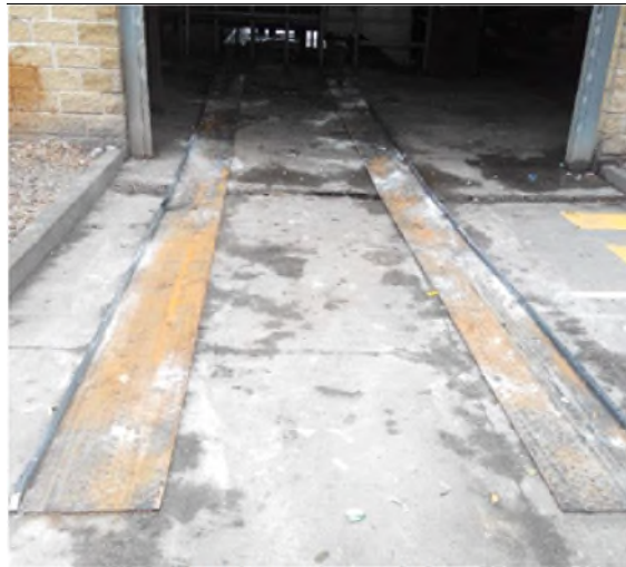
Detalle carriles instalados
