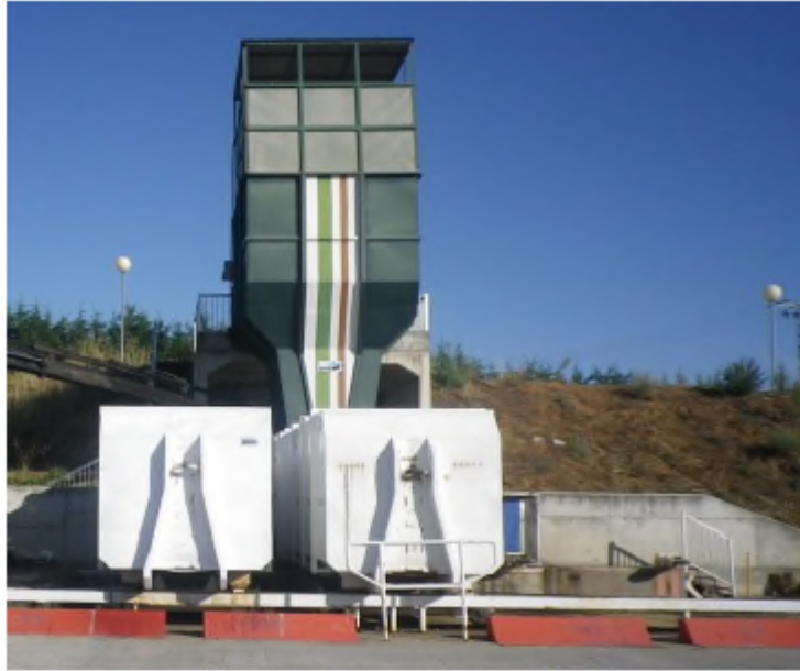
Detalle Estación de transferencias Gujuelo
